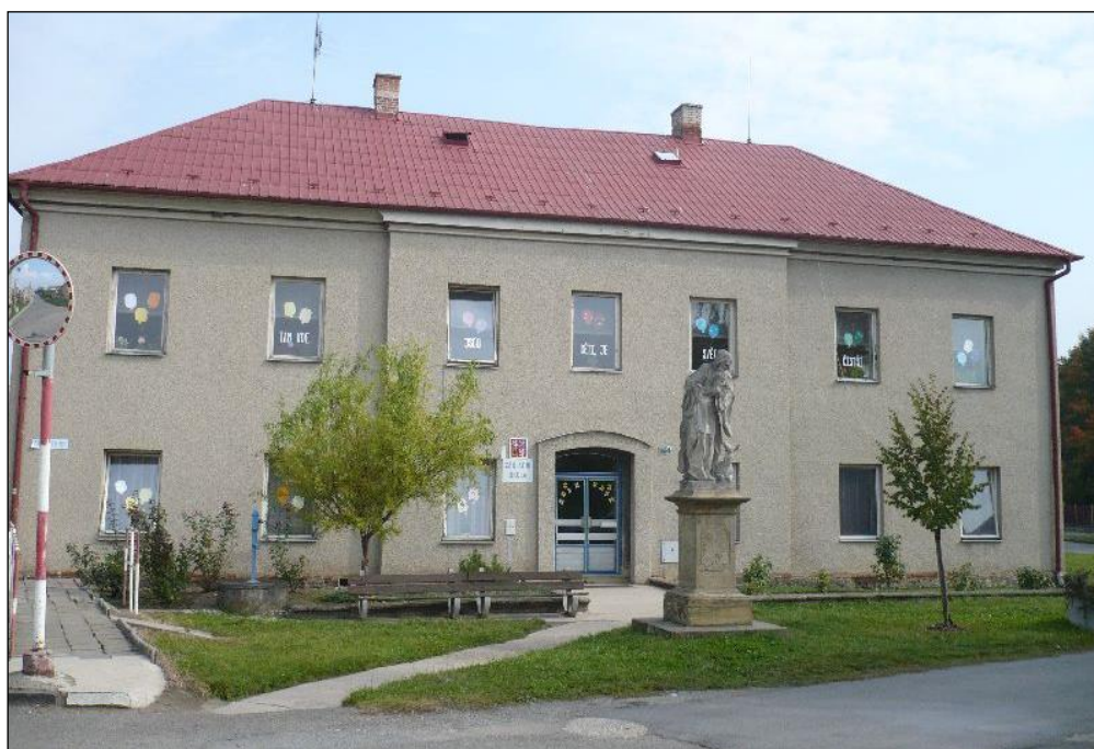
Budova prvního stupně (1. – 3. ročník)
